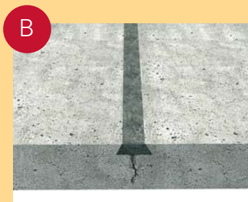
Узел В. Устранение течей сквозь «холодные швы» (швы переменного бетонирования) с помощью шовных составов Emaco и Masterseal.
