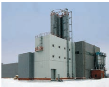
Завод BASF по производству строительной химии в России. Московская область, Подольский район.
