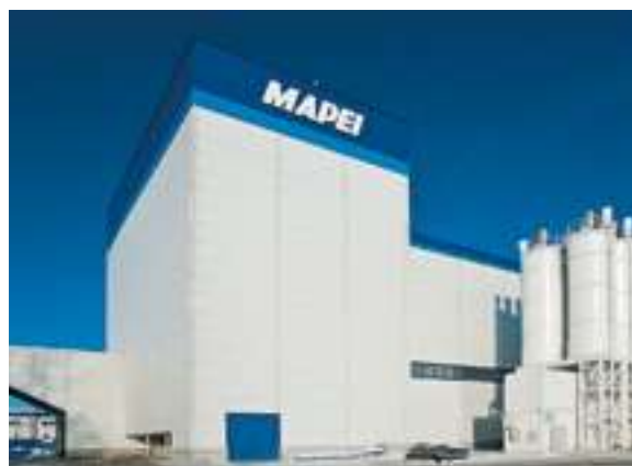
Первая производственная площадка MAPEI в России, г. Ступино, Московская обл.
