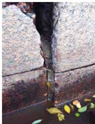
Разрушенные швы, требующие ремонта тиксотропным составом РЕНОВИР РемВод Т
