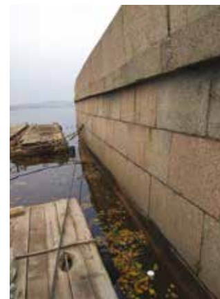
Разрушенные швы, требующие ремонта тиксотропным составом РЕНОВИР РемВод Т
