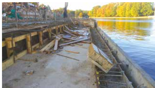
Бетонирование причальной стенки подливочным составом РЕНОВИР Рем60П
