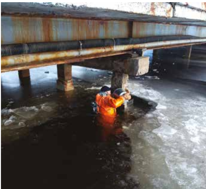
Заливка подвижного состава РЕНОВИР РемВод П в обойму опалубки
