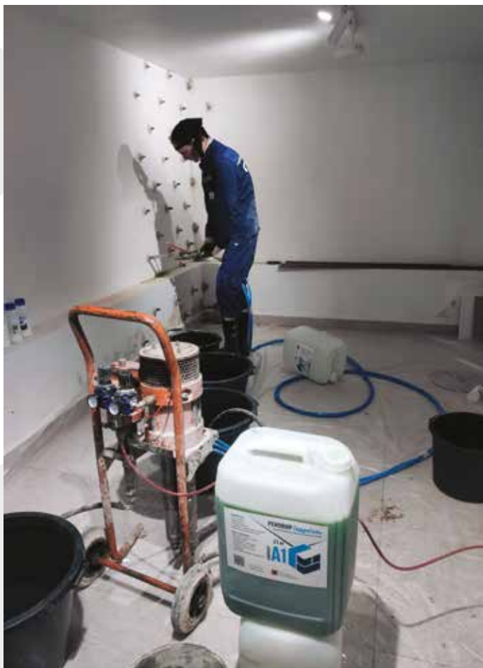
Связывание грунта за конструкцией
