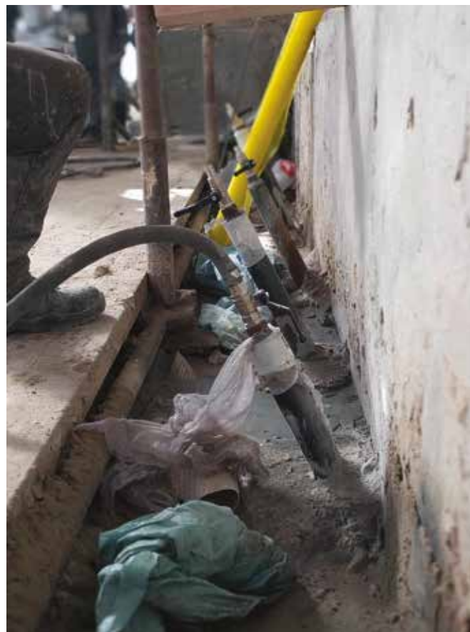
Заполнение дефектов бутового фундамента
