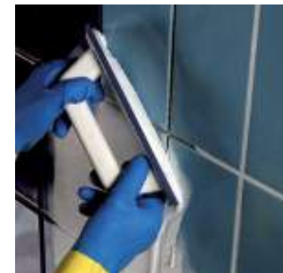
Рисунок 5.6 – Затирка облицовочного материала KERAPOXY CQ
