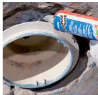
Рисунок 4.2 – Герметизация с помощью пасты MAPEPROOF SWELL
