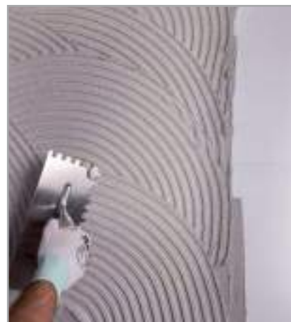
Рис. 6.11 – Нанесение первого слоя накрывочного состава
