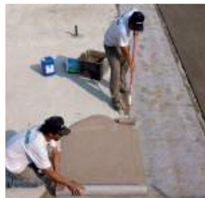
Рисунок 3.6 – Гидроизоляционная обработка с помощью MAPELASTIC SMART и MAPETEX SEL
