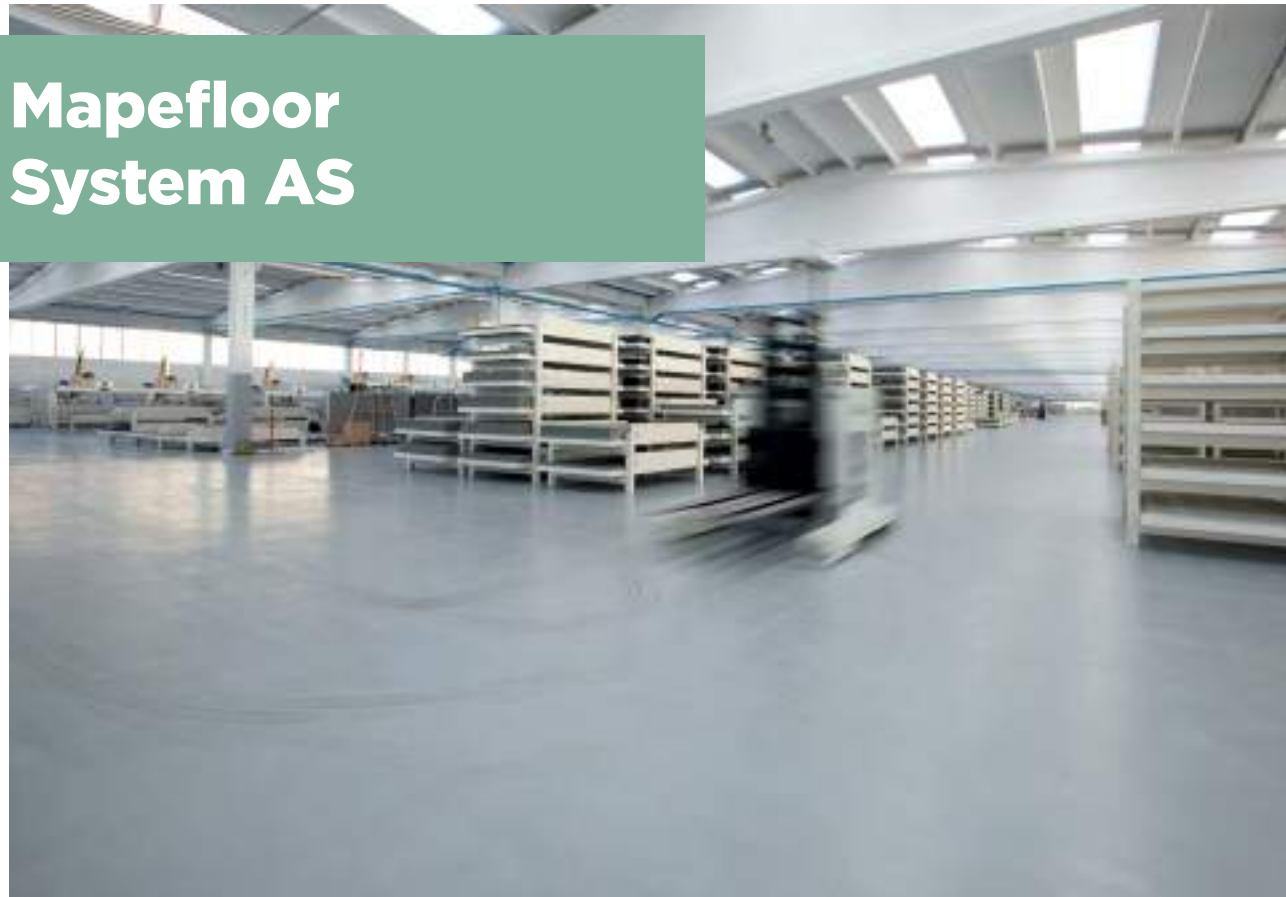
Самовыравнивающееся антистатическое эпоксидное покрытие для промышленных полов. Толщина 1,5-2 мм.
