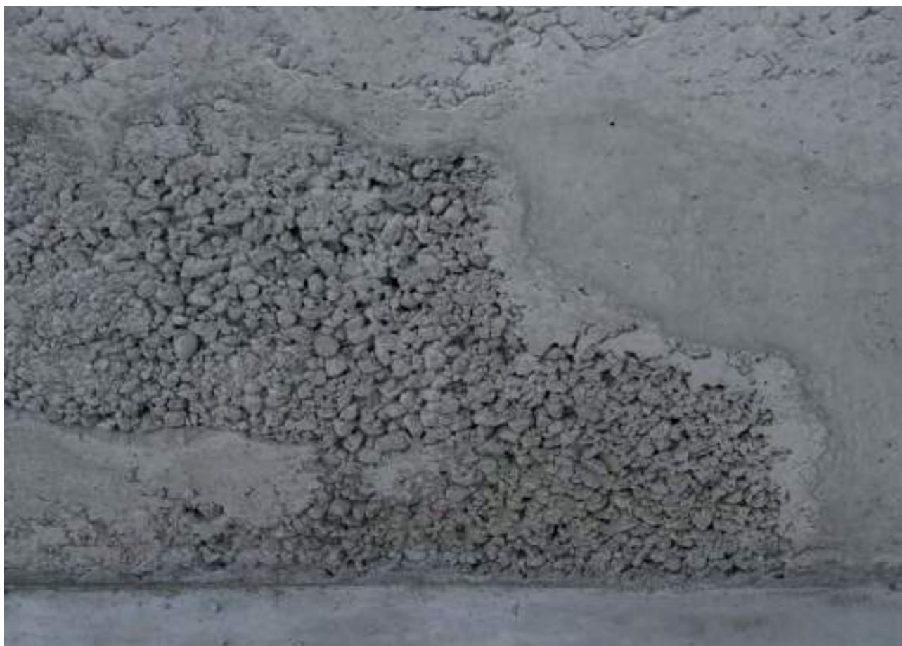
Рис. 21. Разделение заполнителей в бетоне
