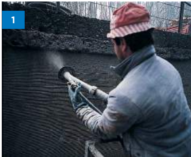
Решение 1. Ремонт вертикальных несущих бетонных конструкций методом набрызга составами тиксотропного типа.
