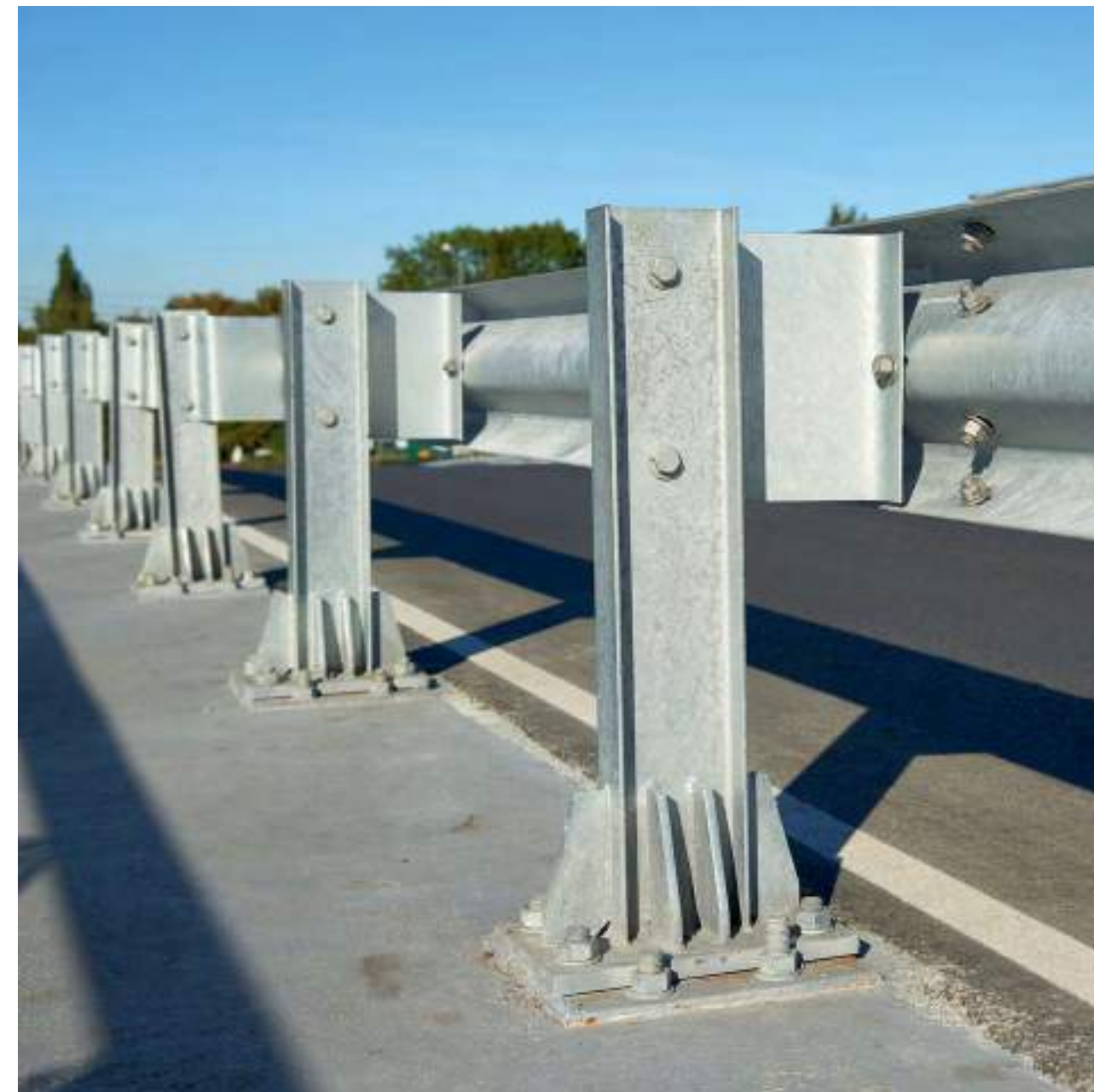
Решение 4. Монтаж стоек дорожного металлического ограждения барьерного типа (мостовая группа) ГОСТ 26804-2012 в условиях отрицательных температур (до -10°C)
