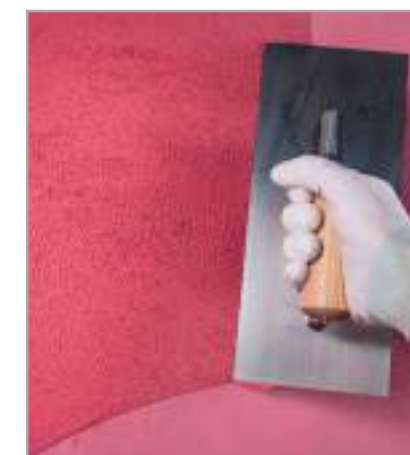
Рис. 6.15 – Нанесение декоративной штукатурки
