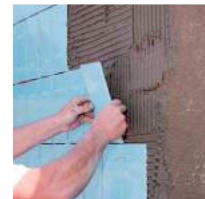
Рисунок 5.2 – Приклеивание плитки на стену с помощью KERABOND T-R , смешанного с ISOLASTIC
