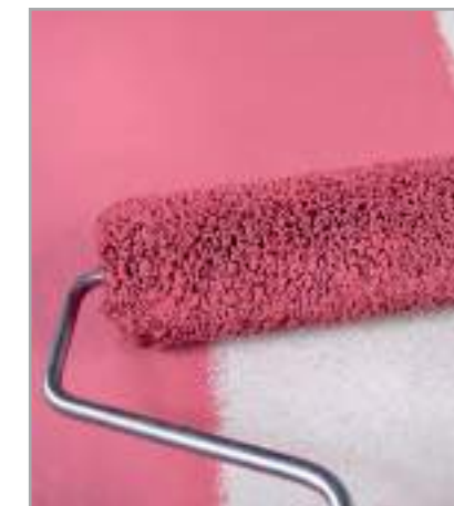
Рис. 6.14 – Нанесение цветной грунтовки
