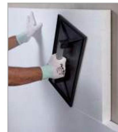
Рис. 6.8 – Придавливание панели гладилкой
