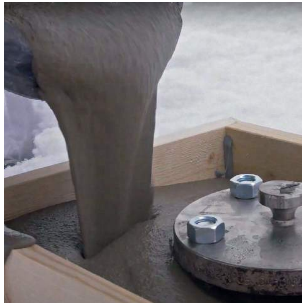
Решение 3. Монтаж металлических колонн, мачт, стоек в условиях отрицательных температур (до -10°С)
