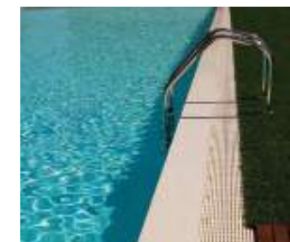
Рисунок 6.1 – Бассейн, окрашенный с помощью ELASTOCOLOR WATERPROOF
