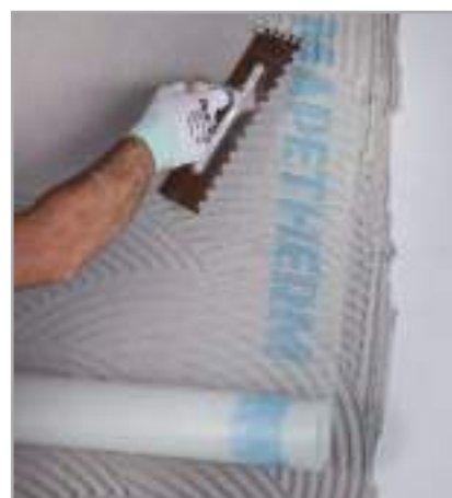
Рис. 6.12 – Укладка MAPETHERM NET
