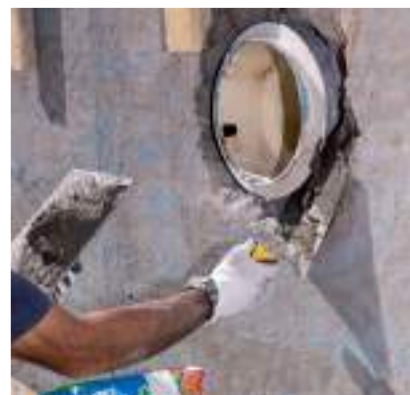
Рисунок 4.3 – Восстановление основания посредством MAPEGROUT 430
