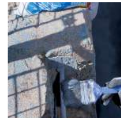
Рисунок 4.1 – Нанесение MAPEFER 1K на арматурные стержни
