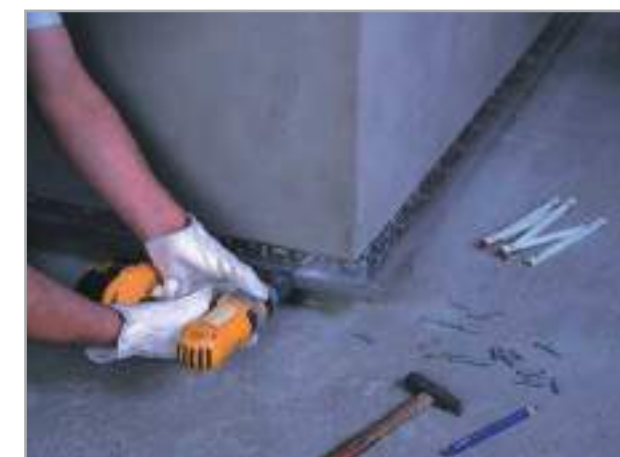
Рис. 6.4 – Закрепите поддерживающие профили с помощью дюбель-гвоздя
