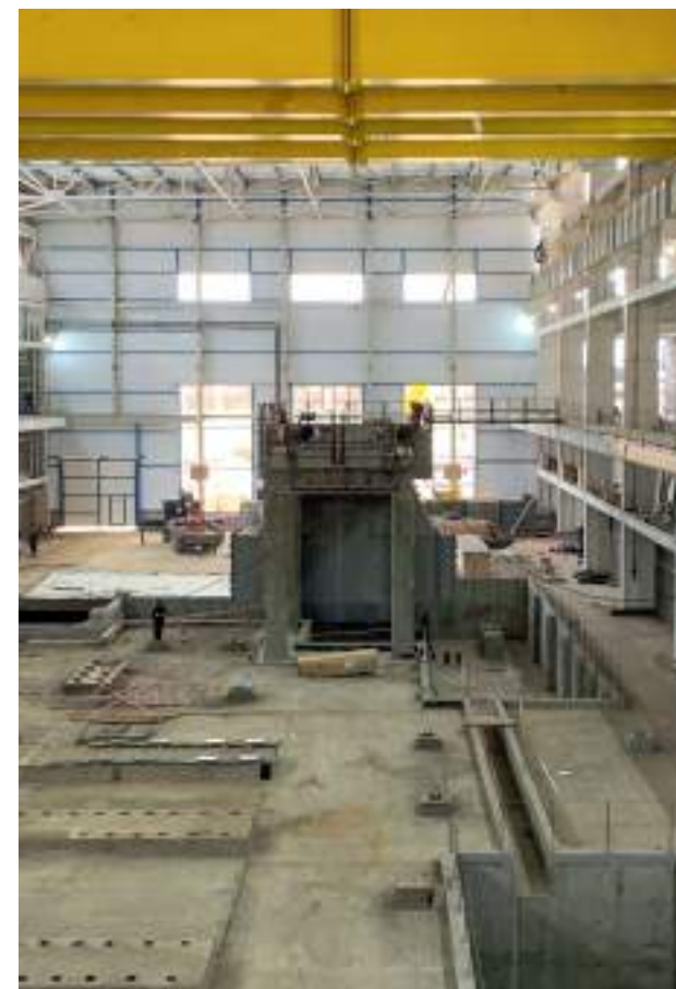
Подливка фундамента турбин, комплексов оборудования и металлоконструкций материалами MAPEI
