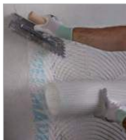
Рис. 6.13 – Края сетки соединяются с нахлестом не менее 10 см.
