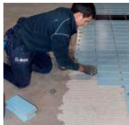
Рисунок 5.3 – Укладка облицовочного материала на дно бассейна
