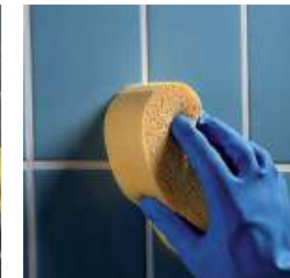
Рисунок 5.8 – Финишная очистка с помощью чистой губки
